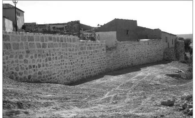
↑ Estado de la muralla después su recuperación.
