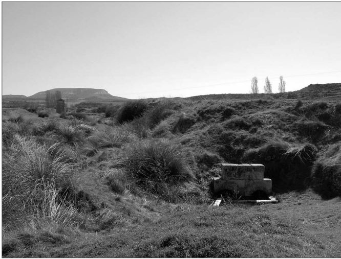
Fuente Vieja antes de las obras
