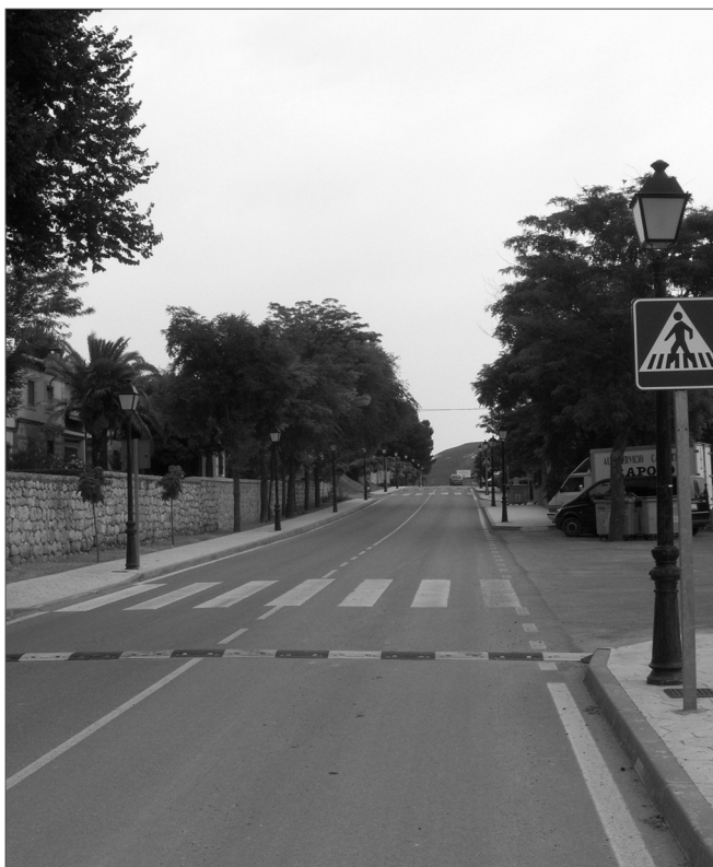
Nuevas bandas reductoras en la travesía de la carretera CM - 1003
