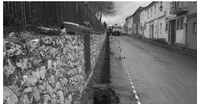
↑ Obras necesarias para la colocación de un nuevo transformador eléctrico.
