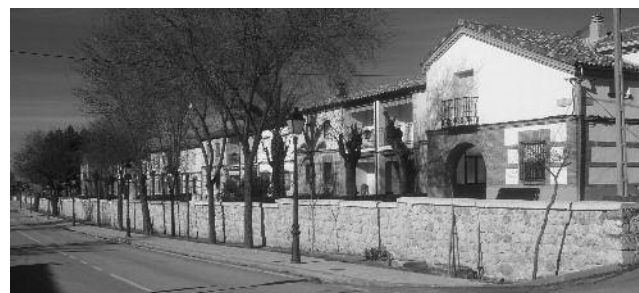
↑ El muro de la calle Guadalajara ha mejorado sustancialmente su imagen.
