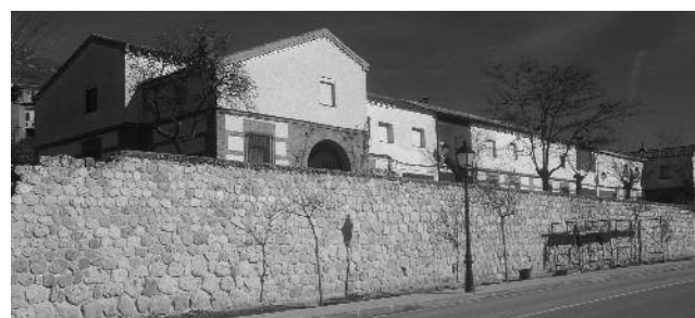
↑ Obras de consolidación y acondicionamiento del muro de la calle Soria.
