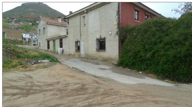
Una de las actuaciones a realizar será la pavimentación de la Calle Aledo.
